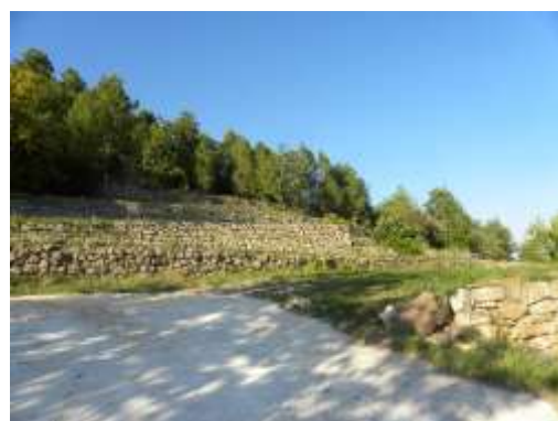
Mur de soutènement en pierre sèche – source : IATE
