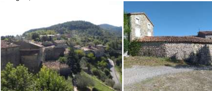
Toiture ancienne - source : IATE
