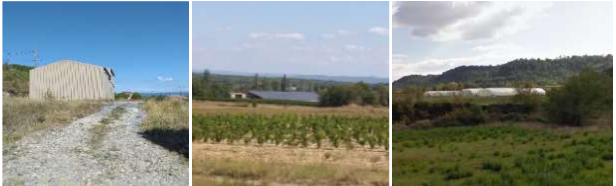
Bâtiments agricoles - source : IATE
